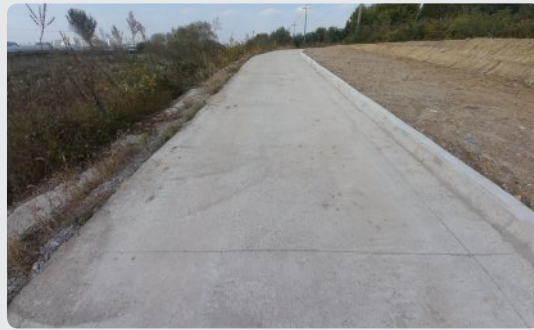
포장 시공상태 양호(평탄성·이음 등)
