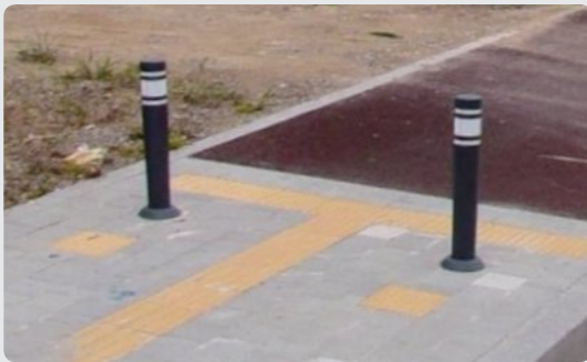
블라드 앞 점자블록 설치
