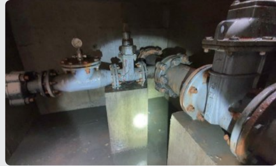
밸브 받침대 시공 양호
