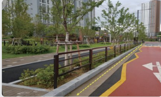
배수상태 양호(경사 적정)
