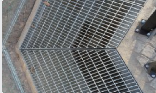
측구 덮개(그레이팅) 시공 양호
