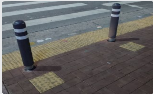
블라드 앞 점자블록 설치
