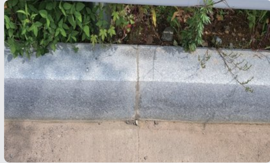
줄눈 모르타르 시공 양호
