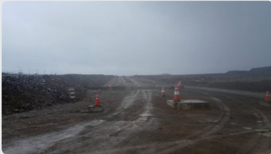
돌출 구조물 안전시설 설치 양호(시인성 확보)
