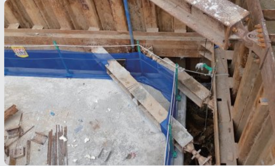
추락위험구간 안전난간 설치
