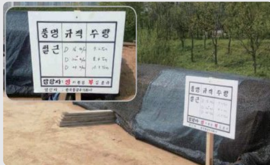
철근 보호조치 양호(녹 발생 및 이물질 부착 방지, 규격별 구분 보관 등)
