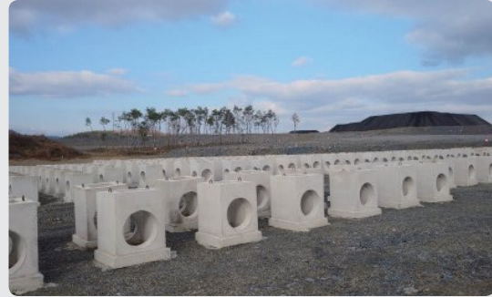
시공계획 변경(현장타설 → 이동제작)승인 미이행
