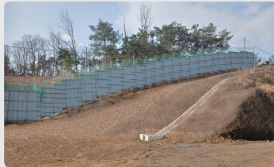
설치 형태(수직) 개선
