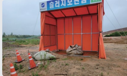
슬러지 보관함 하부 탈수시설 미비
