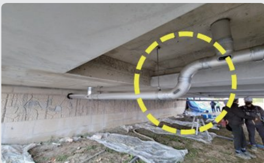
하부 배수시설 설치 부적정(① 불필요 곡관사용, ② 초기우수처리시설 연계 미흡)
