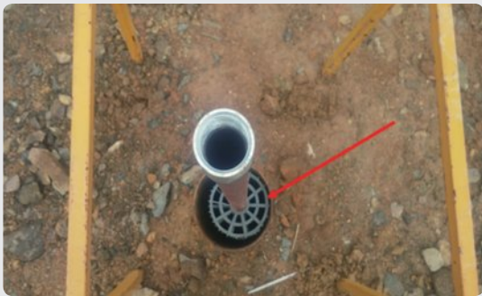
계측기 스페이스 설치
