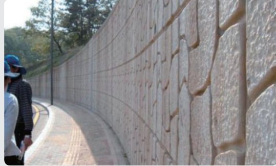
곡선부 시공 양호
