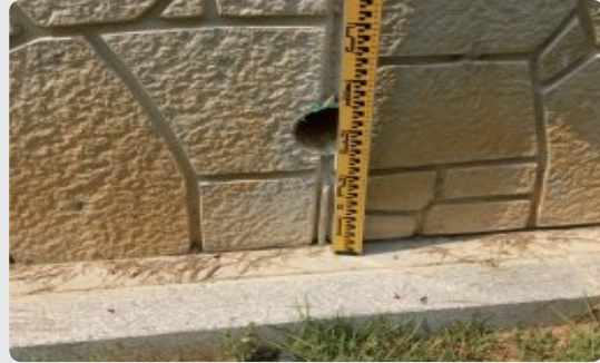
배수구멍 시공 양호(하부 높이 준수)
