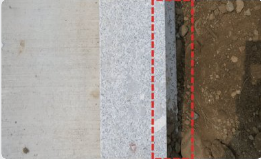
전·후면 거푸집 설치 양호
