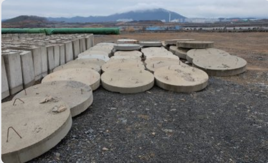
맨홀 슬래브 분리시공
