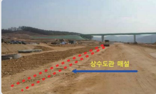
상수관로 수압시험 미 실시(되메우기·포장 완료 상태)
