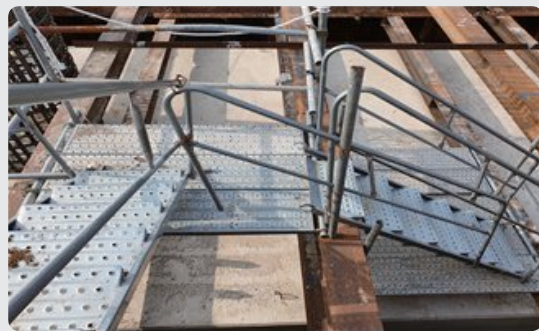
추락 위험구간 안전난간 설치
