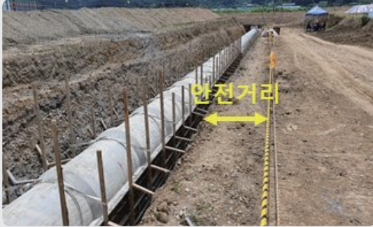
추락 위험구간 안전띠 설치 양호(안전거리 확보)
