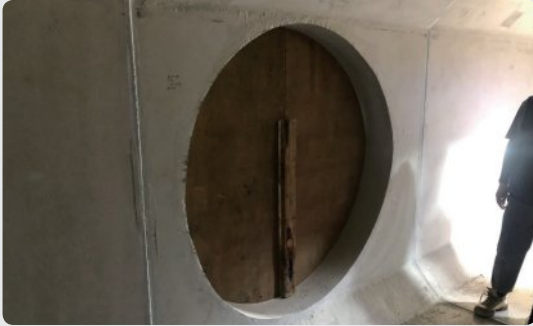
개구부 설치 부적정(① 단면손실 과다, ② 과천공 및 철근보강 미실시)
