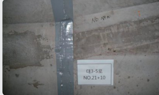
신축이음부 실런트 마감 양호
