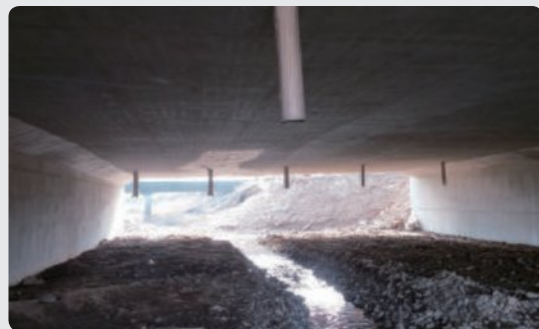
하부 배수시설 설치 부적정(① 불필요 곡관사용, ② 초기우수처리시설 연계 미흡)
