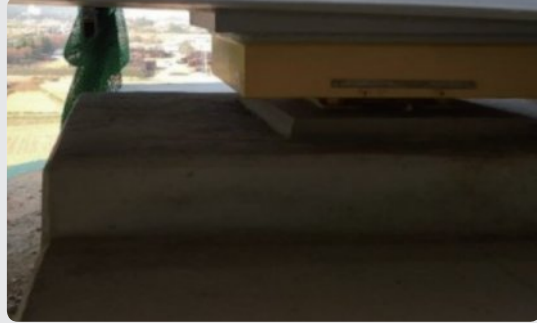
기초 콘크리트 시공 양호
