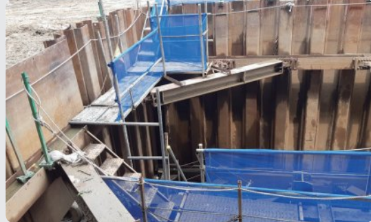
안전난간·추락방지망 설치
