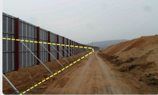
구조계산 후 보조지주 보강
