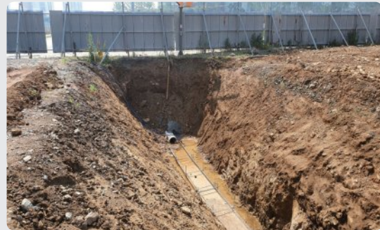
추락 위험구간(터파기 구간 등) 추락·접근 방지시설 설치 미흡
