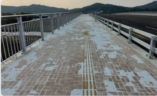
보행자용·차량용 설치 양호
