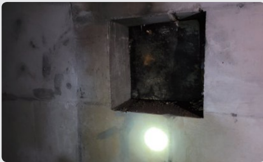
암거 연결관 부위 폐쇄조치 양호
