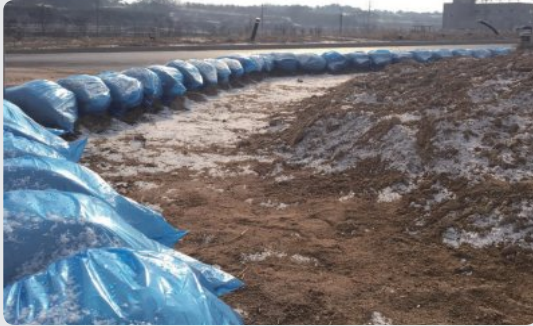
경계석 주변 흙쌓기 높이 조절(토사유출 방지)
