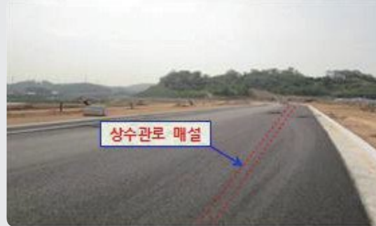
상수관로 수압시험 미 실시(되메우기·포장 완료 상태)
