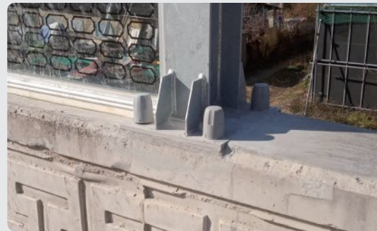
기초 콘크리트 단면 보강
