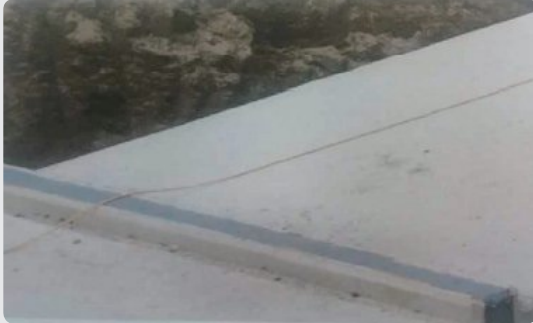
신축이음부 방수턱 설치(물 유입 차단)
