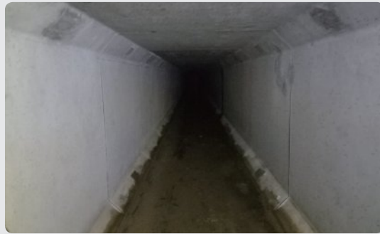
암거 시공 및 유지관리 상태 양호
