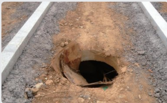
개구부 안전관리 미흡(합판·거푸집 설치, 시인성 불량 등)
