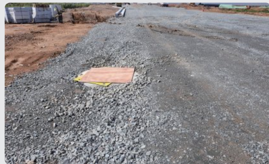
개구부 안전관리 미흡(합판·거푸집 설치, 시인성 불량 등)
