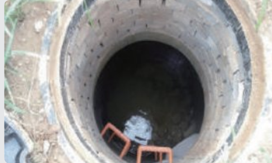
높이조절부 조적(벽돌) 시공
