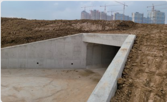
추락 위험구간(터파기 구간 등) 추락·접근 방지시설 설치 미흡
