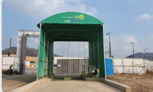
터널형 세륜시설 설치·운영
