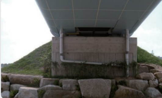
하부 배수시설 설치 양호
