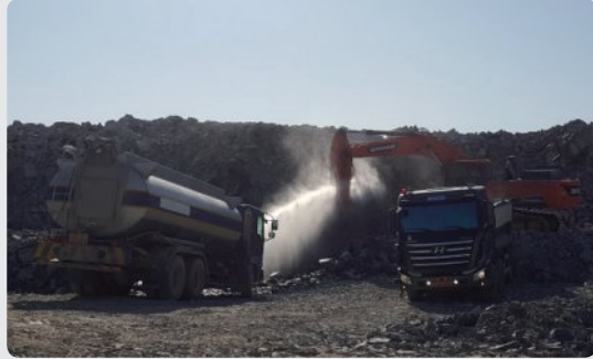
작업 중 살수(기계분사)
