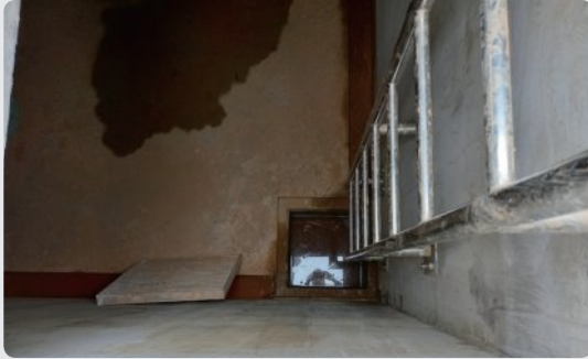
배수피트(PIT) 설치(위치) 양호
