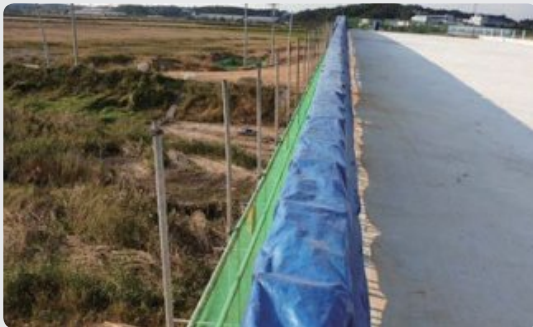
철근 보호조치 양호(녹 발생 및 이물질 부착 방지, 규격별 구분 보관 등)
