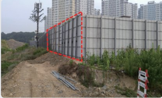
기초지주 개선(H-Beam 설치)
