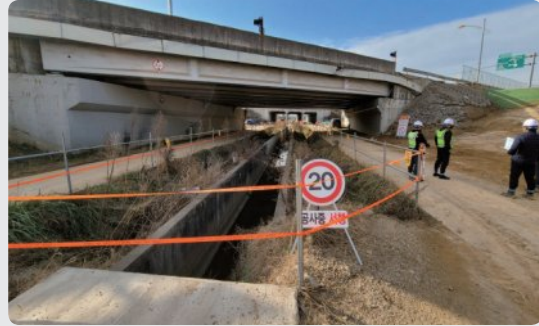
추락 위험구간 안전난간(띠) 설치 양호(시인성 확보)
