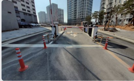
차단기 보호용 U형 볼라드 설치
