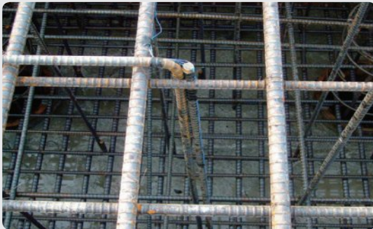
MASS 콘크리트 수화열 측정
