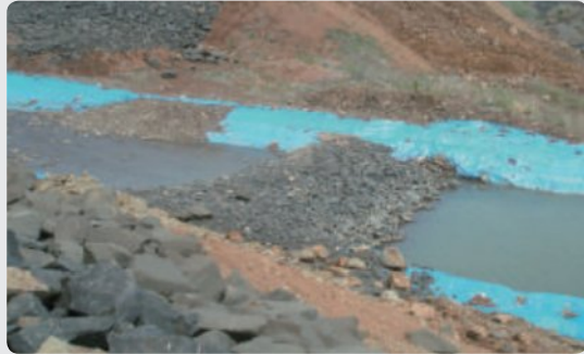
하천 내 사석 스크린 설치 설치
