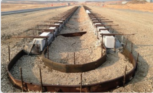
곡선부 거푸집 설치 양호
