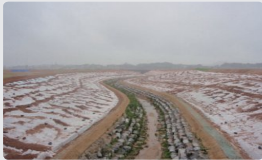
호안공 시공 양호(기울기·맞물림 상태, 식생활착 및 주변조화 등)
