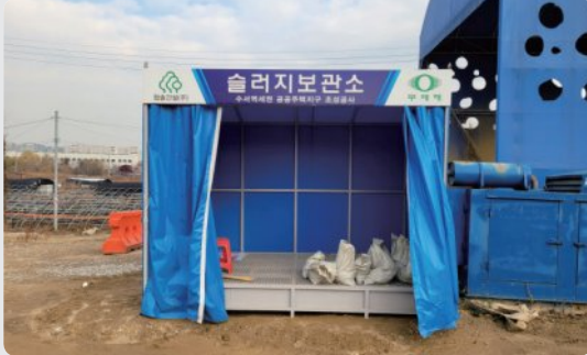
슬러지 보관함 하부 탈수시설 설치
