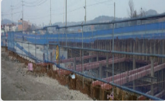
추락위험구간 안전난간 설치
