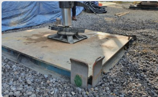
크레인 지지상태 양호
