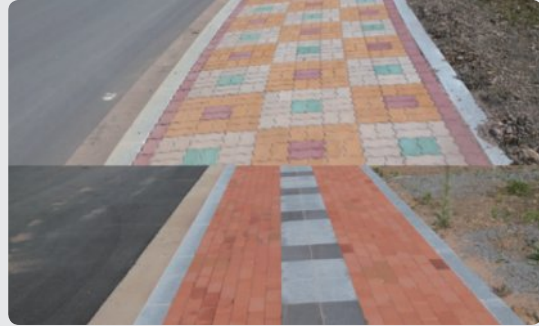
문양배치 양호(시공상세도 작성)
