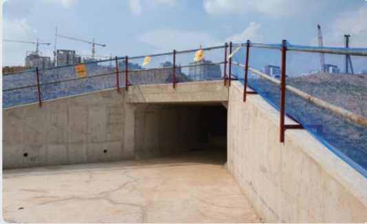
추락 위험구간 안전난간(띠) 설치 양호(시인성 확보)
