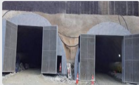
소음저감시설 설치 양호 ① 에어메트+H파일, ② 터널 방음문
