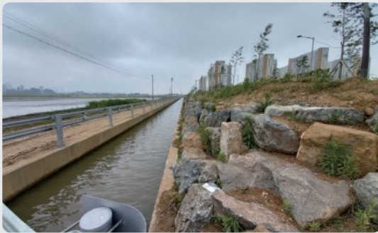
호안공 시공 양호(기울기·맞물림 상태, 식생활착 및 주변조화 등)
