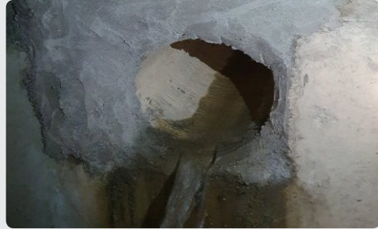
개구부 설치 부적정(① 단면손실 과다, ② 과천공 및 철근보강 미실시)
