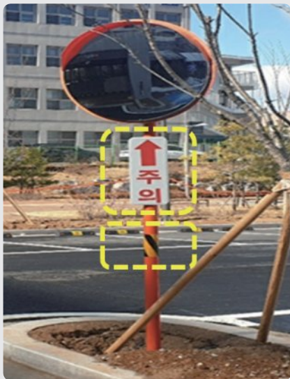
네임시트 · 주의표시 설치 양호
