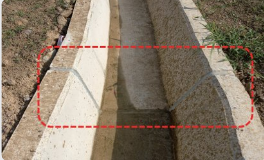
측구 줄눈 설치 양호
