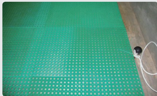
양생수조 공시체 보호판 설치
