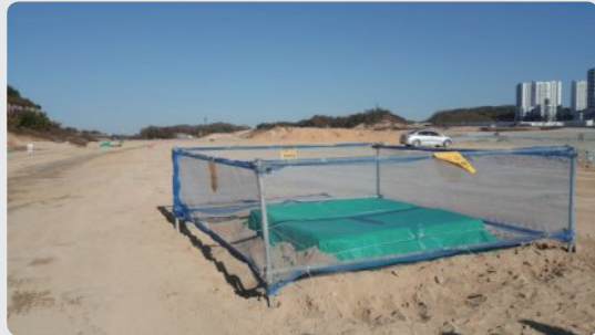
돌출 구조물 안전시설 설치 양호(시인성 확보)
