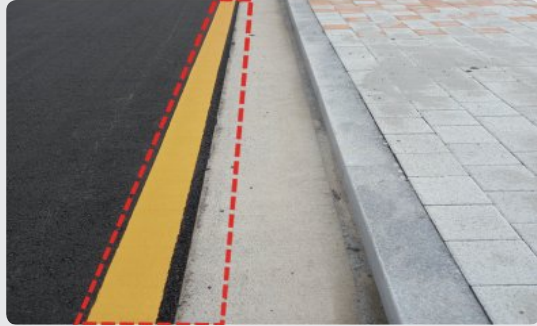
측구 - 포장 접합상태 양호
