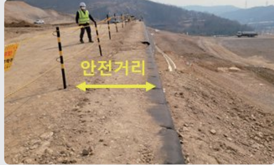
추락 위험구간 안전띠 설치 양호(안전거리 확보)
