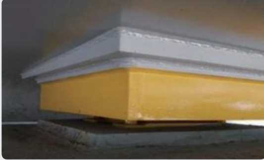
용접·도장 상태 양호
