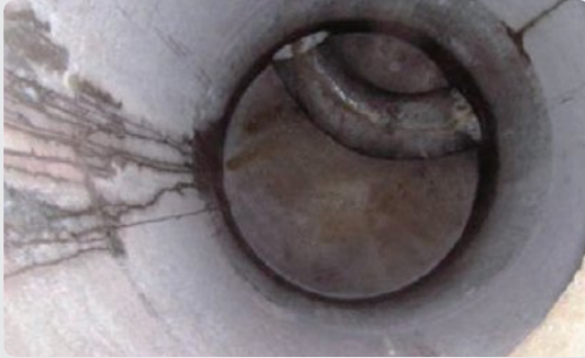
인버트 시공 양호(형상, 경사 등)
