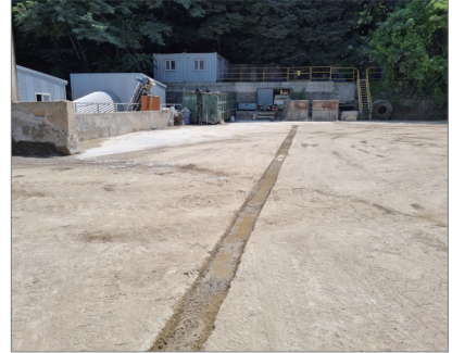
전면부 배수로 전경
