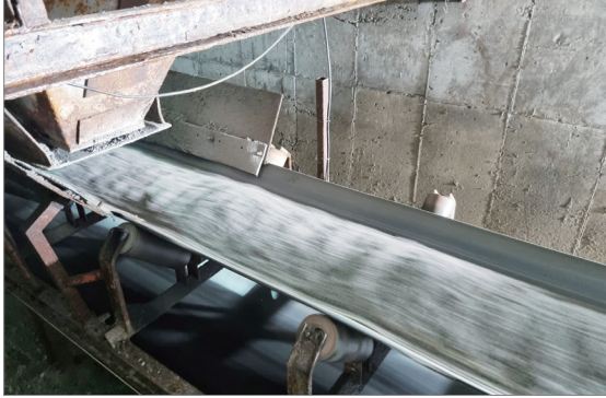
골재 이송(벨트 컨베이어)
