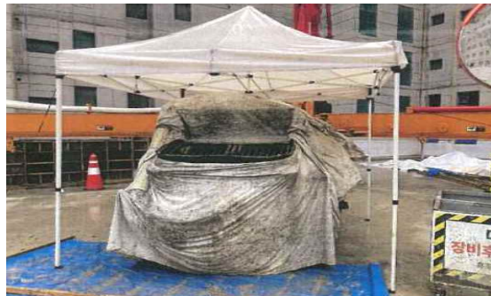
그림 3-11. 펌프카 호퍼외부 천막 설치 예시
