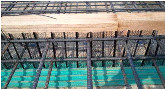
그림 3-13. 메탈라스 설치
