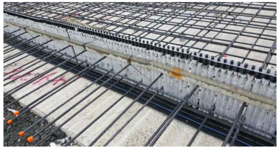
그림 3-14. 기성재 PVC 콘크리트 타설막이 설치
