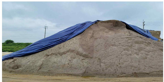
그림 3-4. 천막시트의 잘못된 설치모습
