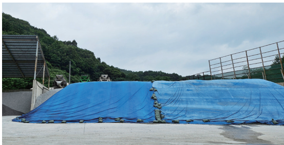
그림 3-3. 천막시트의 올바른 설치모습
