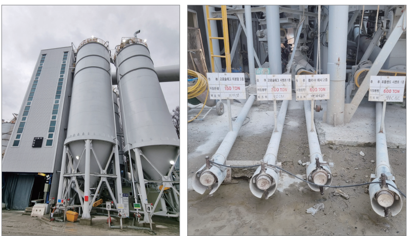
시멘트 사일로 전경 및 현황판
