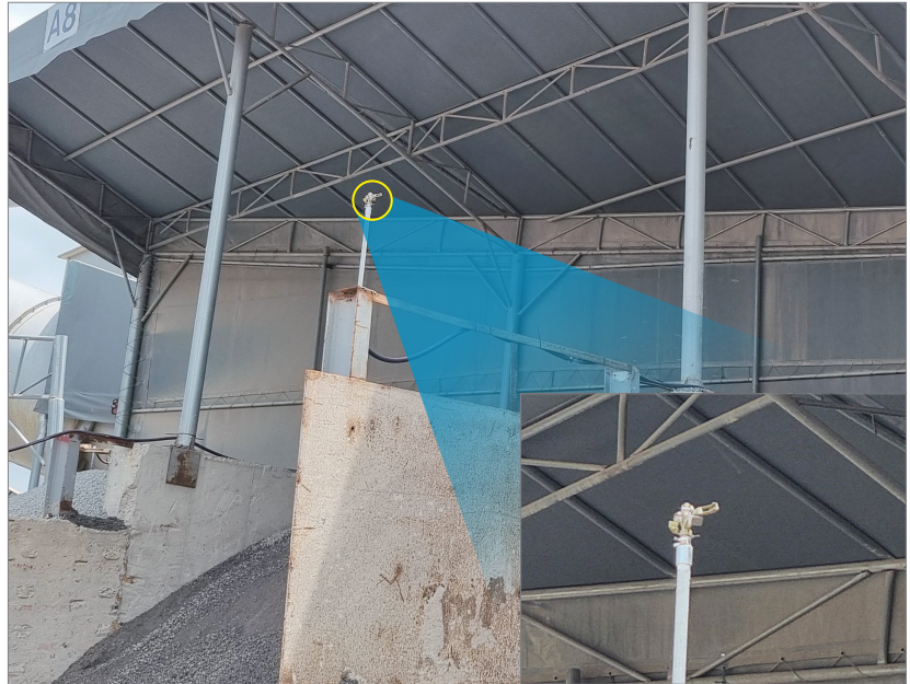
살수 장치(스프링클러) 설치 전경
