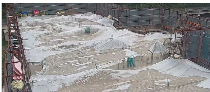
그림 3-12. 콘크리트 타설부위 비닐시트 보호 예시
